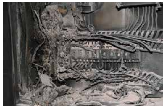
▲ 배전반 화재 사진 _ TS-60은 이러한 화재를 초기에 감지하여 피해를 최소화 하는 제품이다.
